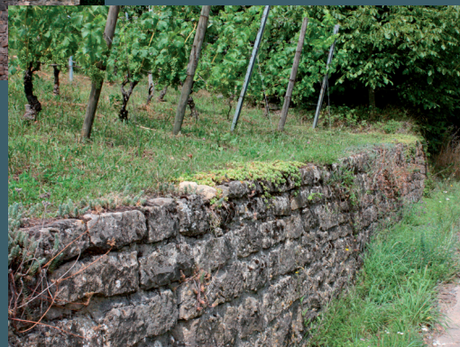
Weinbergsmauer am Kallmuth
